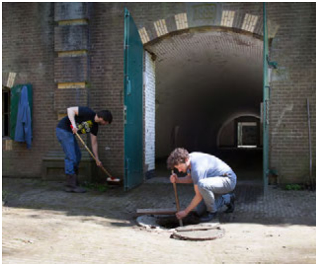
Onderhoudswerkzaamheden door vrijwilligers aan een fort.
